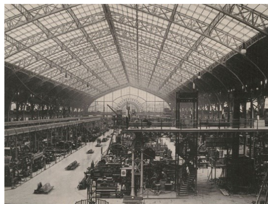
Image I: Galerie des Machines in Paris (1889). 17
